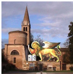
Casa del Sorriso – Badia Polesine
